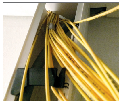
Câble plié et mal installé
