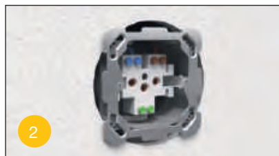
Die Abdeckung wird entfernt
