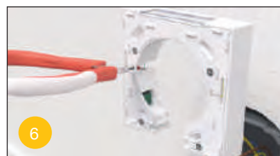
Falls Spreizen notwendig, Steg mit Zange entfernen
