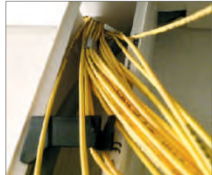
Kabel schlecht verlegt und geknickt
