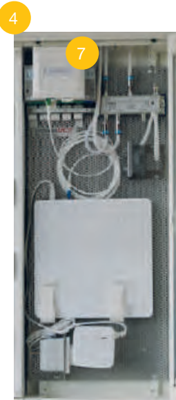
OTO im Verteiler beim Neubau
