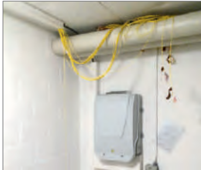
Unordentliche Kabel, nicht durch Kabelkanal gezogen
