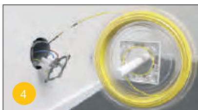
Mit einer Stange, Besenstiel o.ä. kann das LWL-Kabel leicht abgerollt und eingezogen werden.
