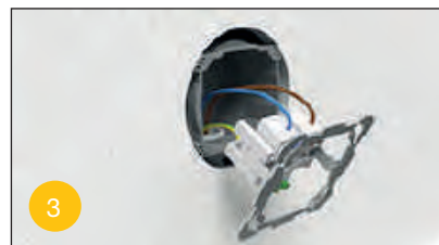
Die Dose wird ein wenig nach vorne gezogen (Drähte bleiben angeschlossen)
