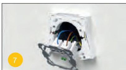
Gespreizte Squeeze Box über Apparat stülpen
